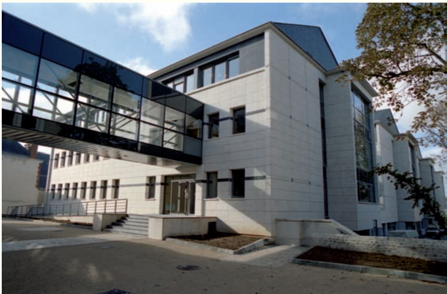
Extensions de l'Hôtel du département construites en 2003 - CG 41 - AD 41
